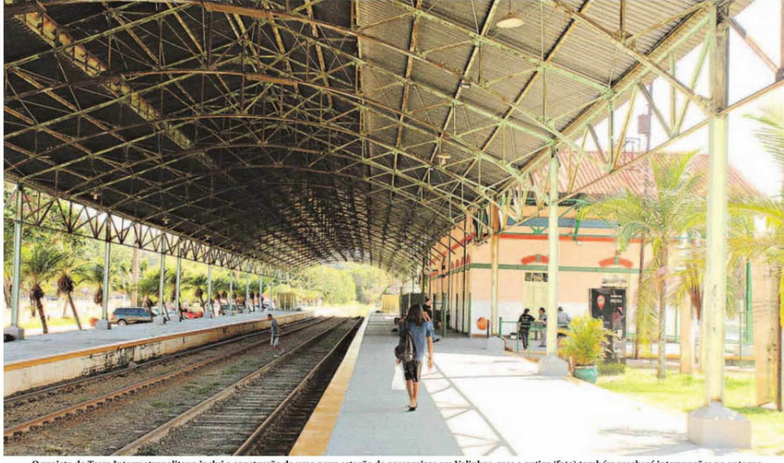
O projeto do Trem Intermetroplitano inclui a construção de uma nova estação de passageiros em Valinhos, mas a antiga (foto) também receberá intervenções no entorno
