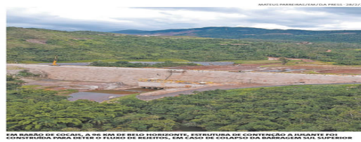
EM BARÃO DE COCÃO, A 20 KM DE BELO HORIZONTE, ESTRUTURA DE CONTENÇÃO A JUSANTE FOI CONSTRUÍDA PARA DEIXAR O FLUXO DE REJEITOS, EM CASO DE ROMPIMENTO DA BARRAGEM DE SUPERIOR
