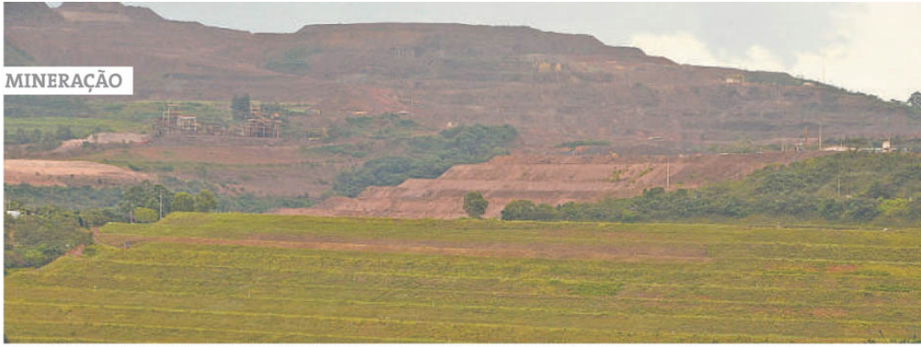
A BARRAGEM DE SERRA AZUL, DA ARCELORMITTAL, UMA DAS TRÊS NO PAÍS EM NÍVEL MÁXIMO DE ATENÇÃO E A ÚNICA QUE AINDA NÃO TEM ESTRUTURA CONCLUÍDA PARA CONTER REJEITOS EM CASO DE ROMPIMENTO
