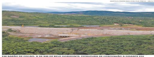
EM BARÃO DE COCÃO, A 20 KM DE BELO HORIZONTE, ESTRUTURA DE CONTENÇÃO A JUSANTE FOI CONSTRUÍDA PARA DEIXAR O FLUXO DE REJEITOS, EM CASO DE ROMPIMENTO DA BARRAGEM DE SUPERIOR
