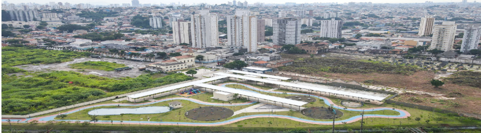
As intervenções apresentadas pelo prefeito José Auricchio Jr. incluem um novo piscinão, muro de contenção, rede de esgoto, macro e micro drenagem, todos os detalhes das obras serão apresentados à população segunda-feira, às 18h, no CISE Sueli Nogueira
