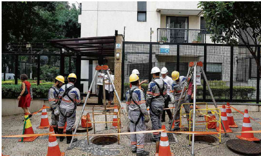
Funcionários na Enel trabalham no restabelecimento de energia na rua General Jardim, na região central de São Paulo, após apagão. Danilo Verpa - 19.mai.24/Folhapress
