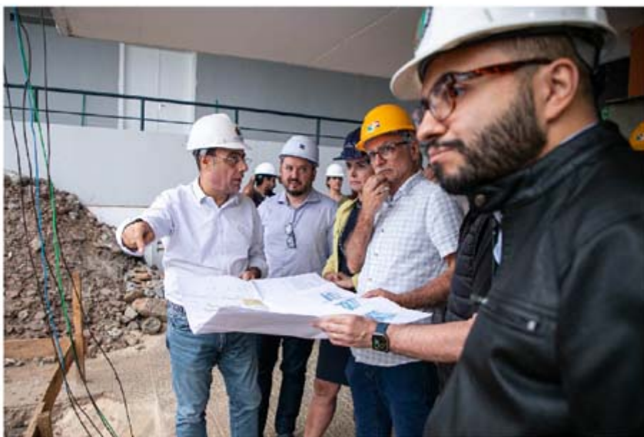
Na próxima semana começarão a subir as paredes. As intervenções serão finalizadas no segundo semestre
