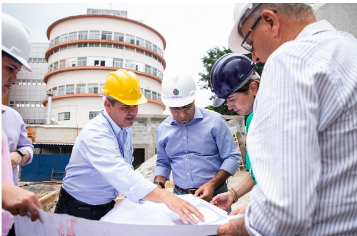
Auricchio vistoria obras do futuro Pronto Cardio, em São Caetano. Foto: Divulgação
