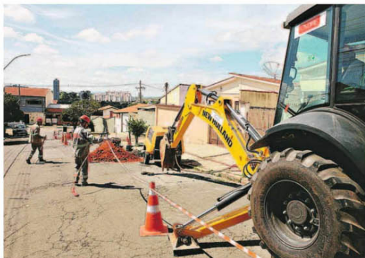
Sanasa investe R$ 150 milhões na troca de 450 km de rede de água, marca que espera atingir até o final deste ano; a modernização da rede pretende diminuir ainda mais o índice de perda na distribuição
