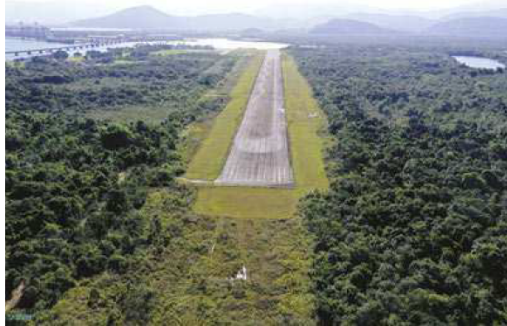
Adaptação de estruturas para recepção de passageiros e acompanhantes deve custar R$ 4 milhões
