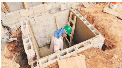
"Na construção civil, só fica parado quem quer. Emprego tem, mas o problema é que ganhamos pouco. A nossa profissão é muito desvalorizada", opinou o pedreiro, contratado neste mês, José Carlos de Oliveira
