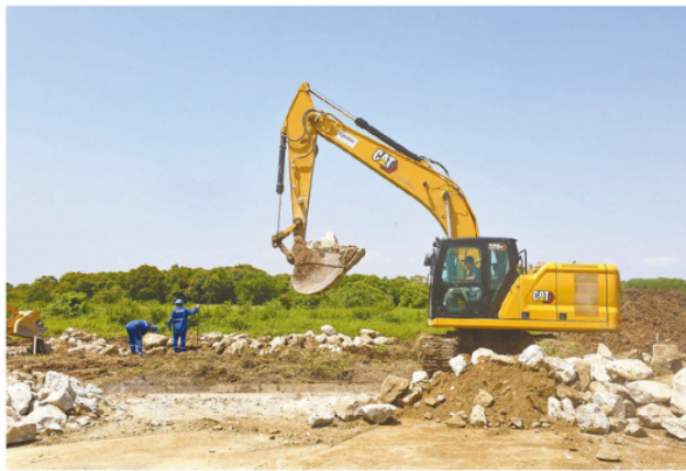
No momento, estão sendo realizados serviços de reforma e adequação da pista de pouso e decolagem, além de outras intervenções
