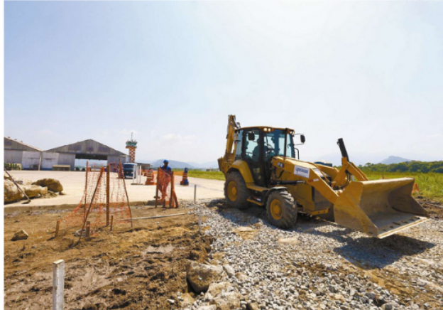
Obras da 1ª fase do Aeroporto Civil Metropolitano de Guarujá começam a mudar a cara da Base Aérea de Santos, em Vicente de Carvalho
