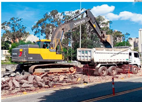
AVANÇO. Obras na Avenida Lauro Gomes, em São Bernardo, seguem após cruzamento com a Avenida Winston Churchill
