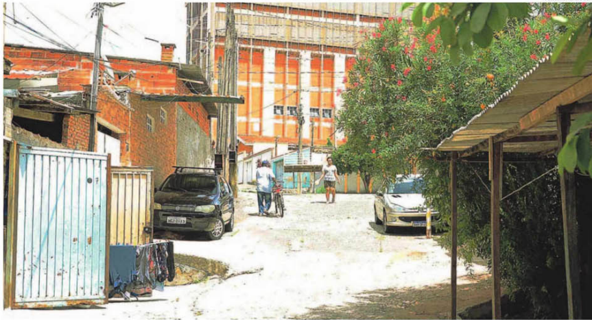
Secretaria Municipal de Habitação encaminhou toda a documentação para o cartório de registro de imóveis para a regularização das matrículas, com os moradores passando a ser legítimos proprietários das residências
