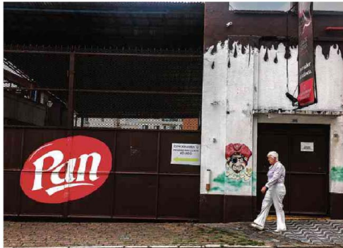
Fachada da fábrica da Pan, no ABC paulista, que já havia sido leiloada. Danilo Verpa - 22.fev.23/Folhapress
