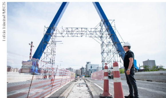
O Viaduto Independência será liberado para o tráfego no sábado (02), mas as obras seguirão
