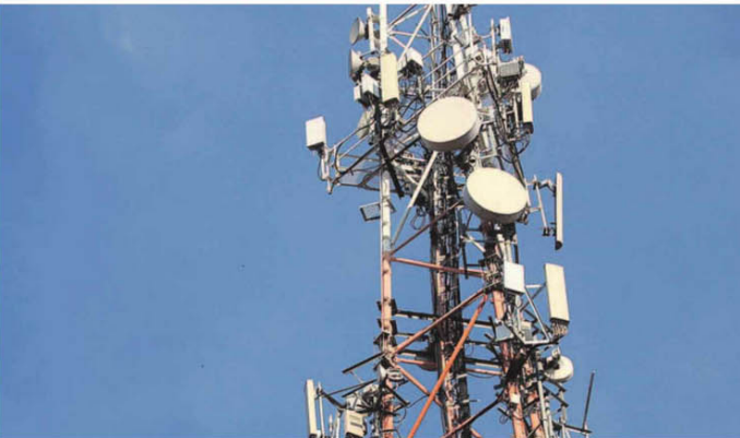
O conceito de RAN compreende tanto hardware quanto software destinados a transmitir e receber dados por meio de sinais de radiofrequência (RF), estabelecendo a conexão entre os telefones celulares dos usuários e as antenas distribuídas nas cidades
