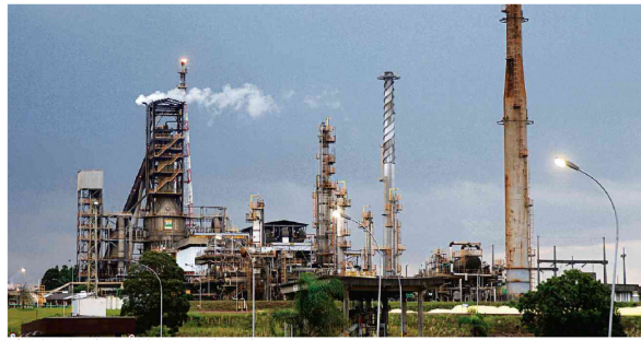
Refinaria de óleo da Petrobras na cidade de São Mateus do Sul, no Paraná. Imagem: Petrobras.
