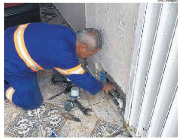
Troca de hidrômetros realizada no Núcleo Edson Gasparini
