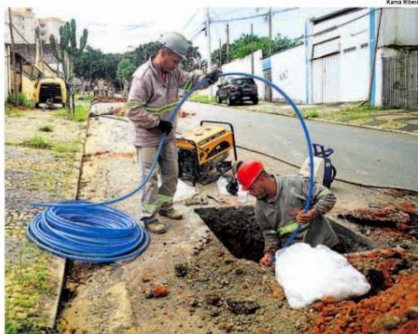
Sanasa prevê a troca de 450 km de redes até o final deste ano, sendo que 350 km já foram substituídos; em 2023, a empresa fez o maior investimento da sua história, ultrapassando a marca de R$ 300 milhões
