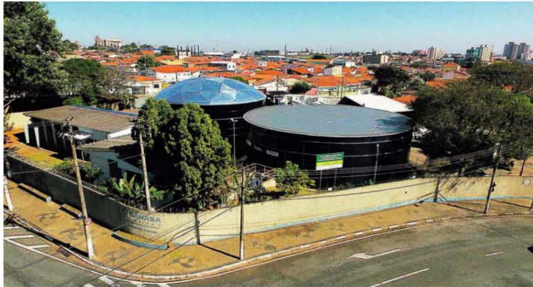
Campinas terá 20 novos reservatórios ainda em 2024, ampliando a capacidade de armazenamento de 12 para 20 horas de abastecimento de água adequado e garantido para praticamente a população inteira da cidade
