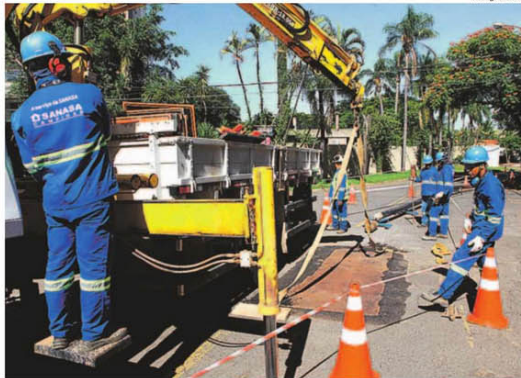
Funcionários da Sanasa durante processo de substituição da tubulação por meio de um método não-destrutivo; na foto à direita, um dos 20 novos reservatórios de água que estão sendo implantados na cidade
