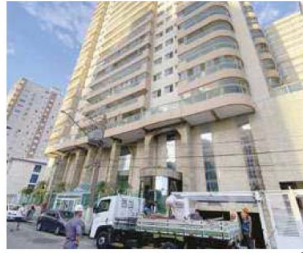
Edifício foi esvaziado em Praia Grande após apresentar problemas
