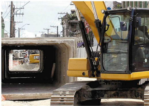
Trabalhos da segunda fase do Veículo Leve sobre Trilhos estão no Paquetá, na Rua Doutor Cochrane
