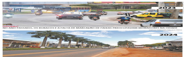
ÁREA URBANA DE MANUAÇU TEM ASFALTO RECUPERADO E PINTURA DEFEITA, MAS MANTÉM ESPERANÇAS
