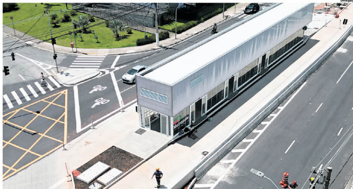
MODAL. Corredor de ônibus de alta velocidade vai ligar São Bernardo à linha metroferroviária da Capital; obra entra em sua segunda fase
