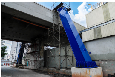
O Novo Viaduto Independência integra o programa Avança São Caetano, com obras 97 obras e um investimento total previsto de R$ 713 milhões.
