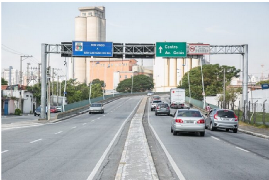
Viaduto Independência de São Caetano fica interditado até 25 de fevereiro. Foto: Divulgação/PSCS
