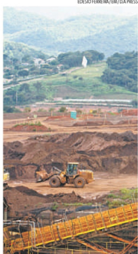
CENA ATUAL DA BARRAGEM CÓRREGO DO FEIJÃO, QUE PASSA POR DESCOMISSIONAMENTO. MÁQUINAS SEGUEM OPERANDO E UM MEMORIAL EM HOMENAGEM ÀS VÍTIMAS SERÁ INAUGURADO
