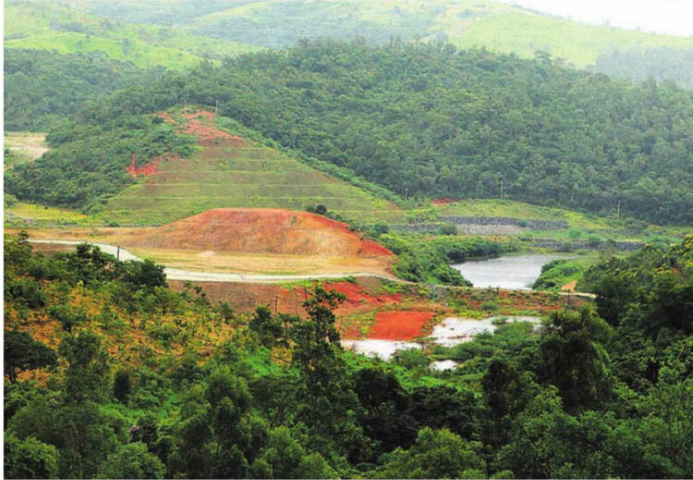
Construção da barragem de Pedreira (foto) foi iniciada em 2018 e estava apenas 42,01% concluída, de acordo com último balanço divulgado pelo consórcio que teve os contratos cancelados pelo DAEE no final de novembro passado; em Amparo, 44,77% da obra estava finalizada
