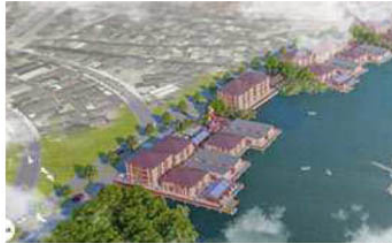
No projeto-piloto, inédito no País, serão construídas 60 casas sustentáveis
