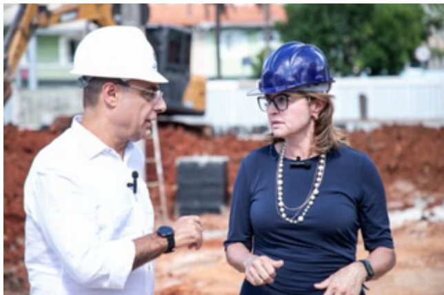
Auricchio e Regina Maura visitam obras de ampliação do Hospital Albert Sabin - Foto: Letícia Teixeira/PMSCS
