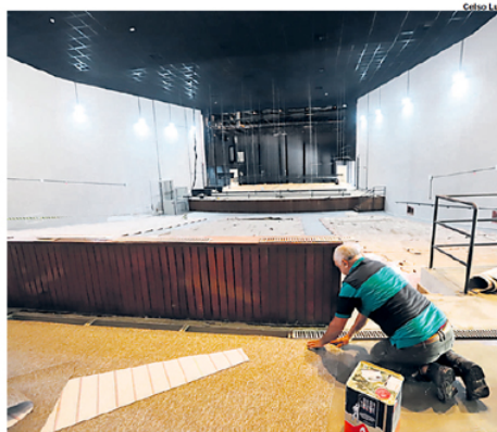
OBRAS. Contrato previa execução da reforma em dez meses
