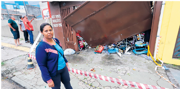
POURPOUCO Ainda assustada, Telma Ribeiro Freitas disse que não foi atingida pelo muro que desabou na Rua Rangel Pestana, em Santo André, por "milagre"
