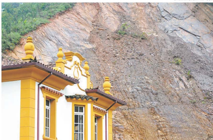
MEMÓRIA E RISCO LADO A LADO: DESLIZAMENTO PRÓXIMO A IMOVES HISTÓRICOS EVIDENCIA A AMEAÇA QUE RONDA A ESTRUTURA URBANA SECULAR DE OURO PRETO
