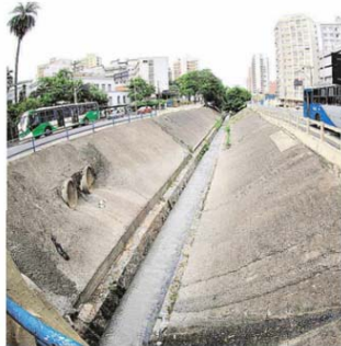
Ao todo, são oito obras no plano que pretende acabar com as enchentes nas bacias dos córregos Serafim (foto) e Proença
