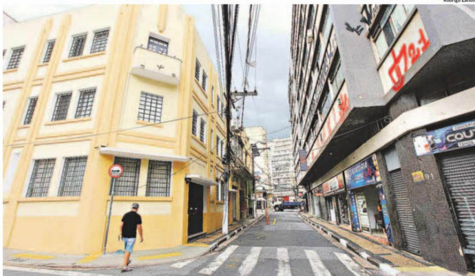
Mais três projetos, que estão em análise na Prefeitura, poderão, em breve, se beneficiar com a Lei do Retrofit, um no Largo do Rosário, outro na Rua César Bierrebach (foto) e o terceiro na Praça 9 de Julho
