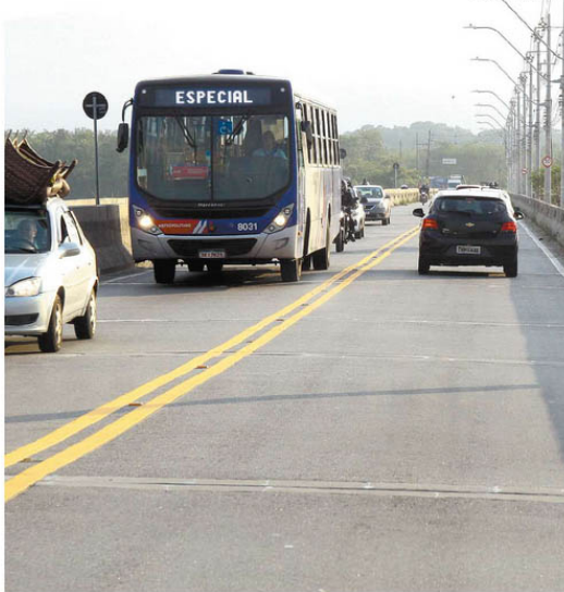
Obras na Ponte A Tribuna (dos Barreiros), com início previsto para janeiro, terão custo de R$ 193 milhões
