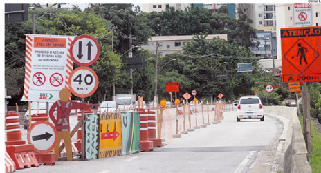
FASE 1. Construção do corredor segregado no trecho de São Bernardo está praticamente concluída
