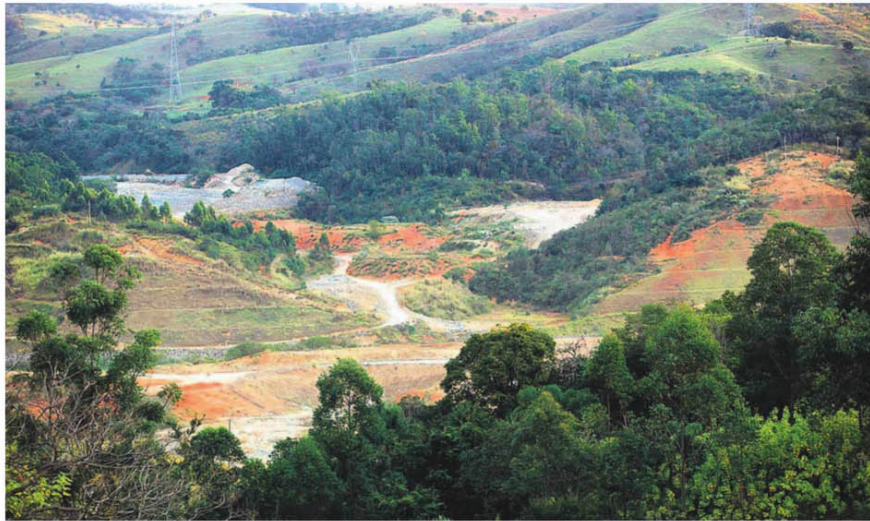
Barragem de Pedreira, logo após o anúncio da interrupção das obras pelo Estado: retomada dos empreendimentos ampliará a segurança hídrica em 28 municípios localizados na Bacia dos Rios Piracicaba, Capivari e Jundiá
