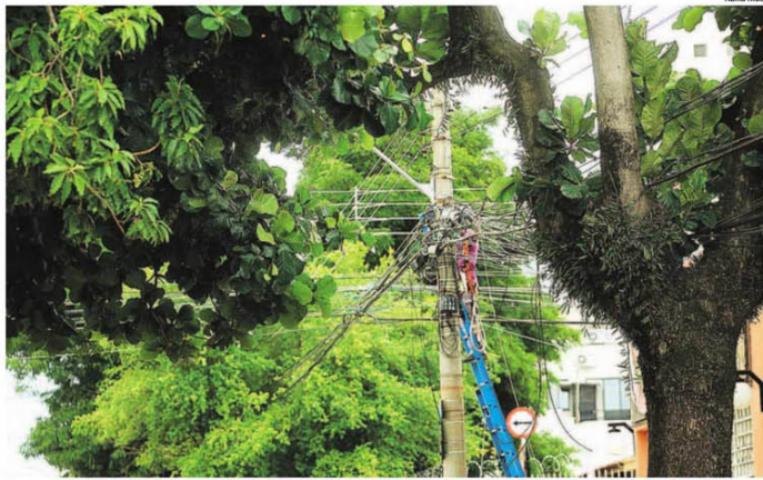
Prefeitura e CPFL Paulista assinaram um convênio para que a empresa possa remover, com autorização da Administração, árvores condenadas e abaixo da fiação elétrica; a cada exemplar retirado, serão doadas 25 plantas nativas ao município
