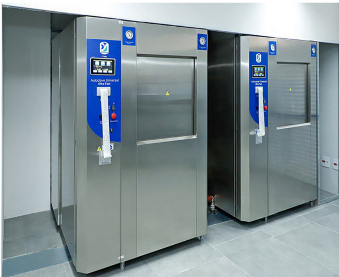
Central de Material e Esterilização conta com espaço total de 168 m 2 .
