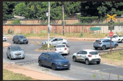
No Guarã, próximo à colônia agrícola Águas Claras, a linha férrea está bem ao lado de uma creche. A sinalização horizontal é praticamente inexistente e há um deslize na pista
