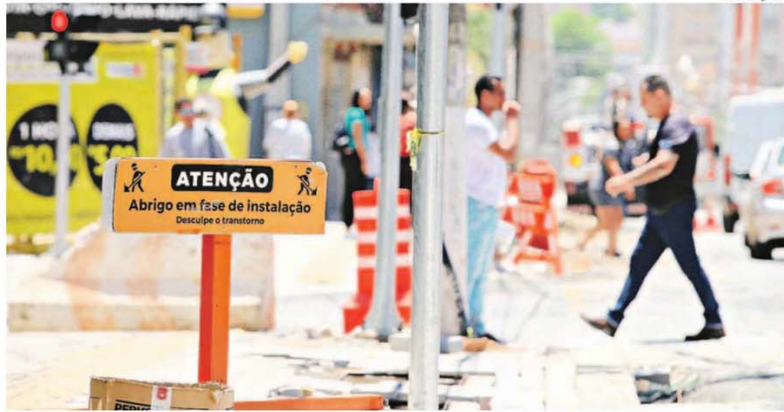
Embora causem transtornos, as obras de revitalização da Avenida Campos Sales têm a aprovação dos comerciantes, que esperam que as melhorias ajudem a atrair mais consumidores
