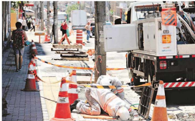
Entre as intervenções que estão sendo realizadas na via estão o aterramento dos cabos elétricos, alargamento de calçadas, instalação de mobiliários urbanos e colocação de novo sistema de iluminação
