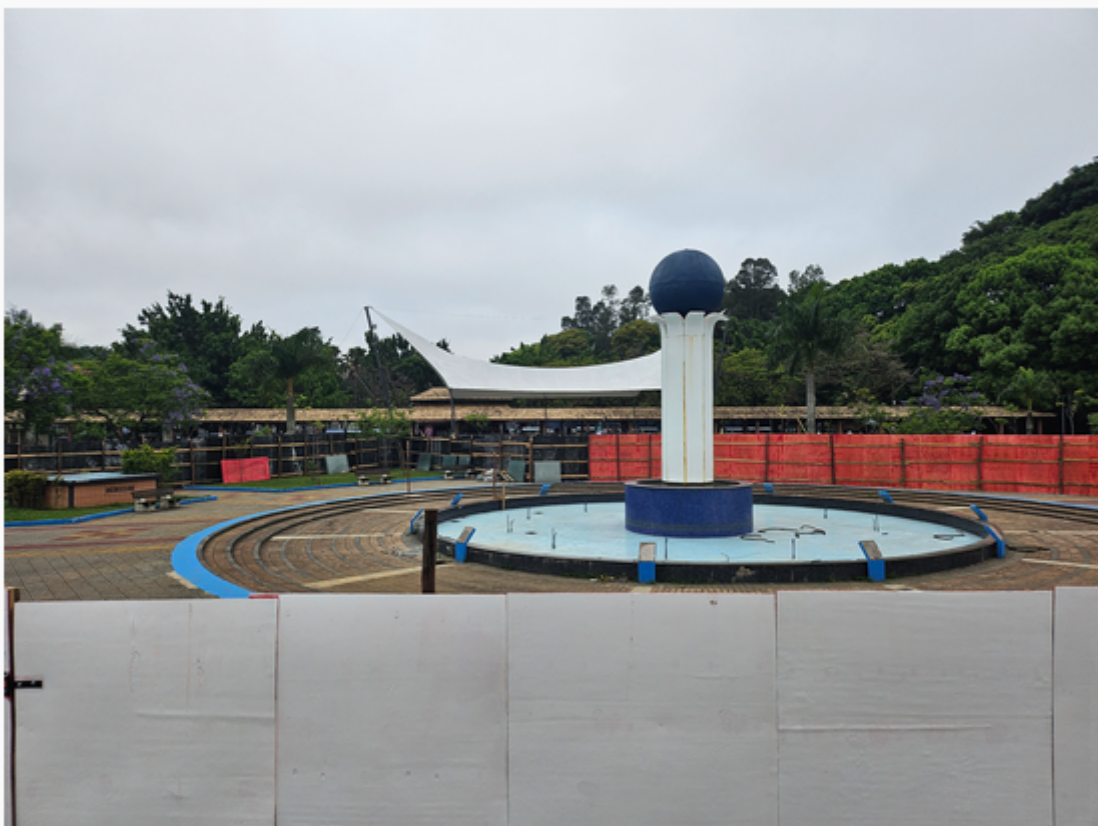
97 Obras serão feitas em toda a cidade. Autor: Raissa Santos.
