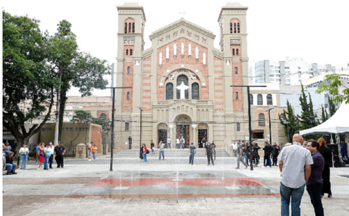
A área foi totalmente remodelada, de piso drenante a iluminação em LED, com um investimento total de R$ 6 milhões
