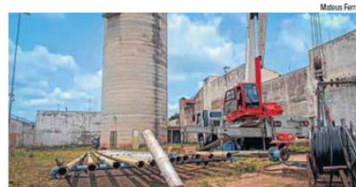
Equipe da Eletromecânica do DAE iniciou a substituição do equipamento nesta quarta-feira
