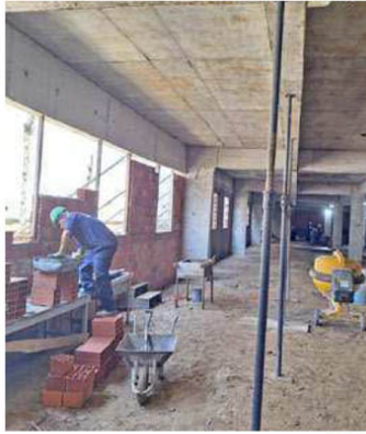
As obras do primeiro Complexo Materno Infantil de São Vicente estão 35% concluídas; entrega esta prevista para 2024
