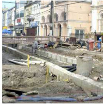
Primeira fase do Parque Valongo deve ser concluída em julho de 2024
