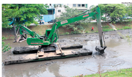
OPERAÇÃO. Sto. André realiza limpeza mecânica no Piscinão Santa Teresinha, localizado na várzea do Rio Tamanduaté
