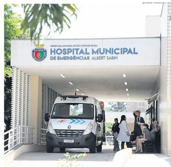
OBRAS. Equipamento ganhará novo pavimento e terá cerca de 700m²
