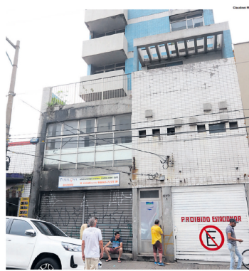
PARTICULAR. Inssores deixaram o prédio à tarde, depois de a GCM chegar. BO foi registrado
