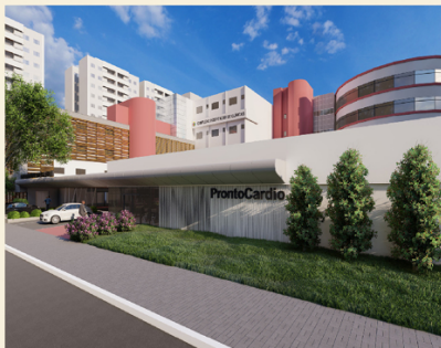
O Pronto Cardio está sendo construído no Complexo Hospitalar de Clínicas, na Vila Brasil Filho. Funcionará 24 horas por dia, 7 dias por semana.
